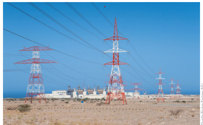
Bild 1 Modernes Gas- und Dampfturbinenkraftwerk am Golf von Oman bietet zukünftig eine Kapazität von 2 000 MW Modern gas and steam turbine power plant at the gulf of Oman will provide in future a capacity of 2 000 MW
