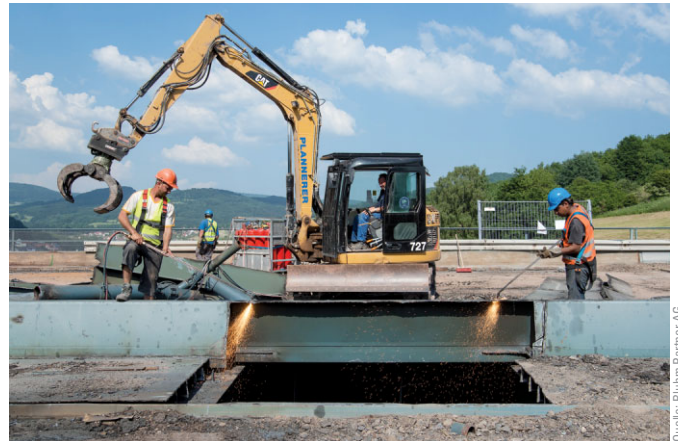
Bild 4 Entfernen der Gehwegkrägarne zur Reduktion des Fallgewichtes Remove of the walkway cantilevers to reduce the drop weight
