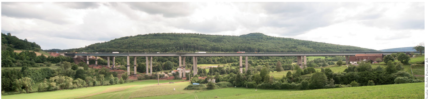
Bild 1 Neue und alte Sinnthalbrücke bei Bad Brückenau mit Widerlager Süd (links) und Wohnhäusern (Mitte und rechts) New and old Sinnthal bridge at Bad Brückenau with abutment south (left) and residential buildings (center and right)
