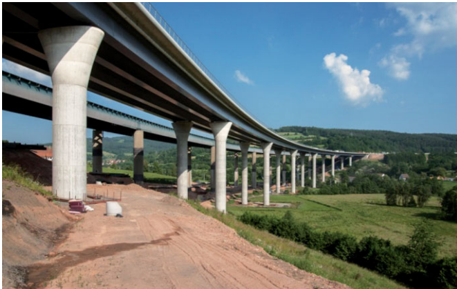
Bild 2 Im Hintergrund die alte Sinntalbrücke mit Widerlager Nord (links) und Widerlager Süd (rechts); links im Bild das Brückenpfeilerpaar der Achse 1; im Vordergrund die neue (zu schützende) Sinntalbrücke In the background the old Sinntal bridge with abutment north (left) and abutment south (right); on the left the bridge pier pair in axis 1; in the foreground the new (to be protected) Sinntal bridge
