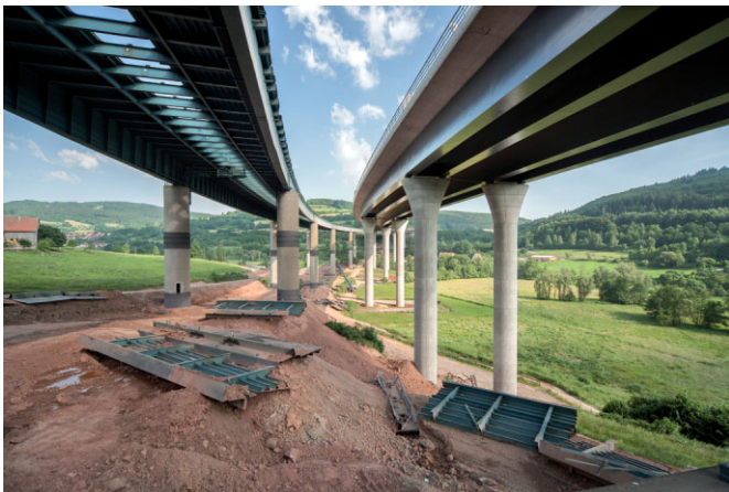
Bild 3 Brückenüberbau der alten Sinntalbrücke (links) und Schutzwälle mit Lastverteilern (Gehwegkrägarne) einige Tage vor dem Sprengabbruch Bridge superstructure of the old Sinntal bridge (left) and ramparts with load balancers (walkway cantilevers) few days before demolition
