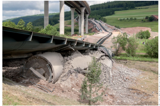
Bild 8 Brückenüberbau und Brückenpfeiler der alten Sinntalbrücke nach dem Sprengabbruch Bridge superstructure and bridge pier of the old Sinntal bridge after the demolition
